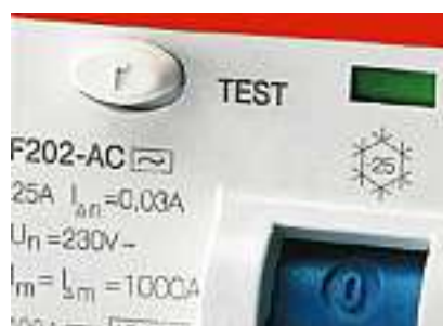
Typ AC, wechselstromsensitiv. Seit NIN 2010 in der Schweiz nicht mehr zugelassen.
