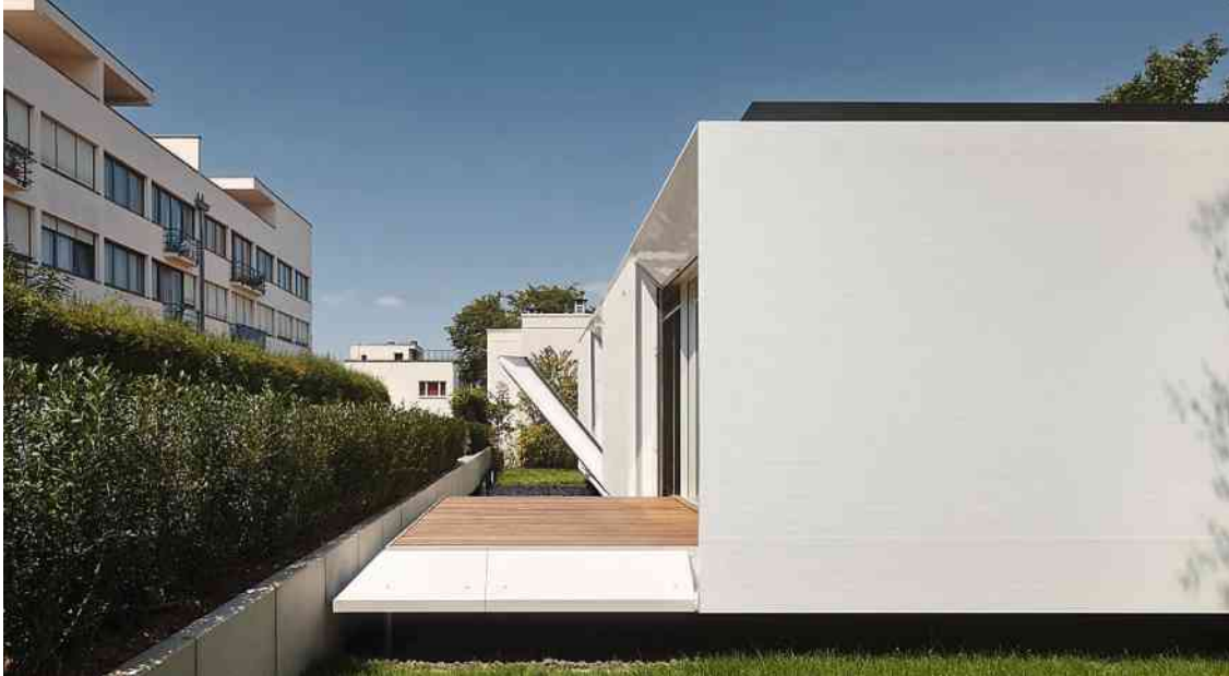
Schliessbare Fassadenklappen verringern die Nachtauskühlung im Winter und Überhitzung im Sommer.
