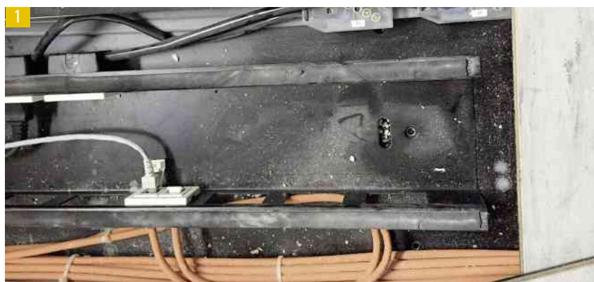
Flachkabel-Anschlussgarnituren.
