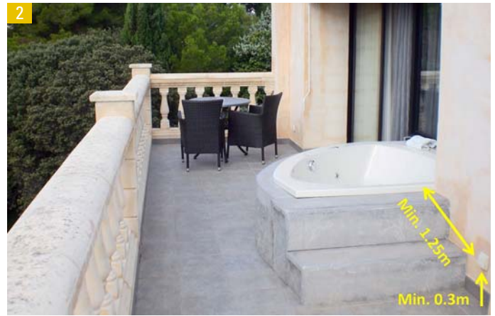
Zwei Beispiele von Bassins auf Terrassen. Die Steckdosen müssen ausserhalb des Handbereiches der Bassins angeordnet sein.
