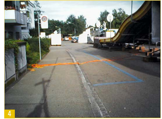
4 Schlechtes Beispiel: Kabel im Bereich von Fussgänger- und Fahrzeugpassagen.
