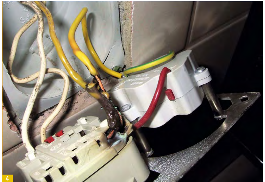
4 Mangelhafter Neutralleiteranschluss.
