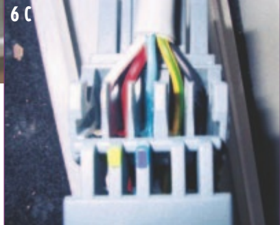
Abbildungen zu Frage 6: In den Abbildungen sehen Sie Anschlüsse in Neuanlagen, bei welchen Schutzleiter unter Spannung standen. Finden Sie die Fehler!
