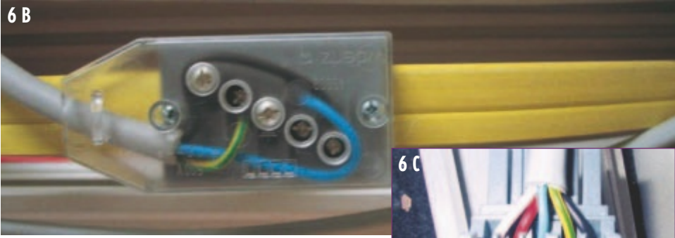
Abbildungen zu Frage 6: In den Abbildungen sehen Sie Anschlüsse in Neuanlagen, bei welchen Schutzleiter unter Spannung standen. Finden Sie die Fehler!
