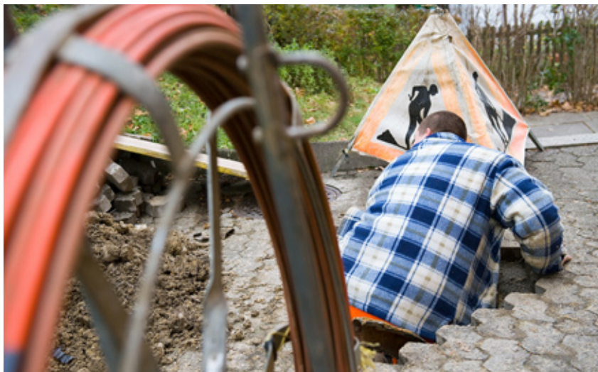
Glasfaserbau im Anschlussnetz von Swisscom.
