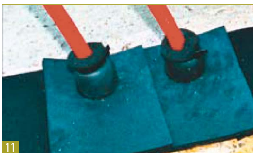
9,10,11 Leitungsführungen in die Wand bei einer eingelegten Bodenleitung.
